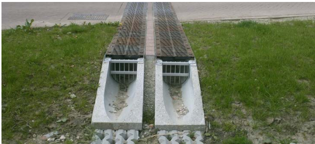
Figuur 12 Voorbeeld vuilrooster in roostergoot
